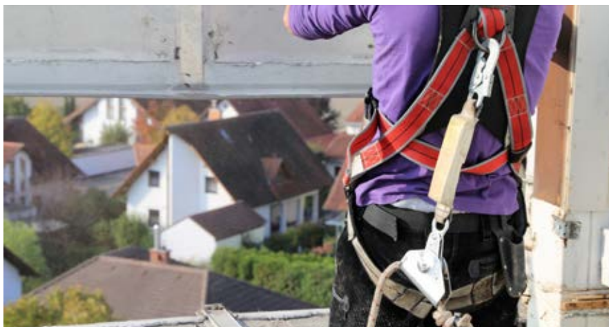
Jeder Mitarbeiter einer Baufirma sollte die Regeln der Persönlichen Schutzausrüstung gegen Absturz (PSAgA) kennen und fachgerecht anwenden können.
